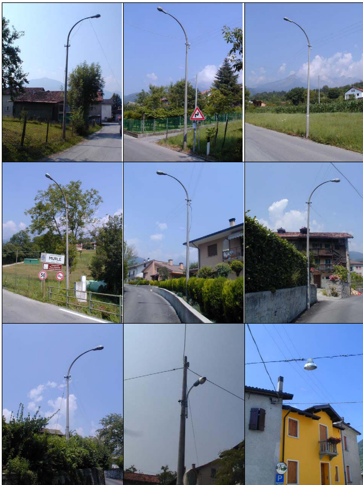
Figura 1.31 – Situazioni che necessitano interventi
