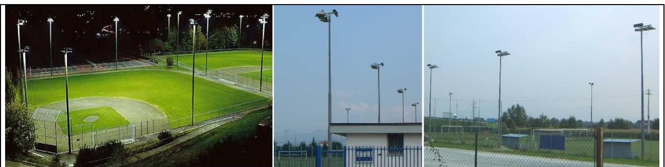
Figura 2.10 - Impianti sportivi illuminati in modo conforme alla L.R. 17/09 con proiettori asimmetrici orientati orizzontalmente e che non disperdono luce verso l'alto.
