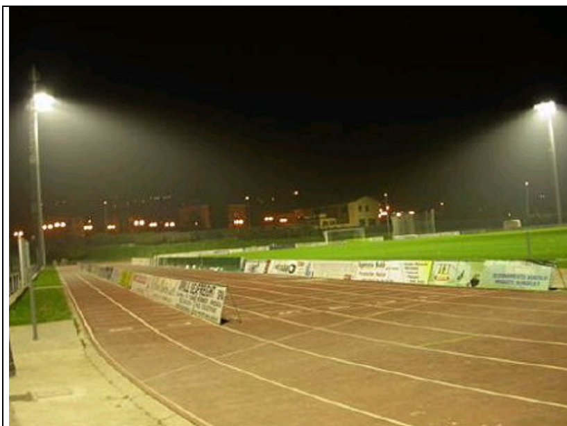
Figura 2.11 – Salò (Bs): impianto sportivo di grandi dimensioni conforme alla L.R. 17/09
